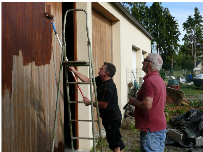
Des portes du garage communal
